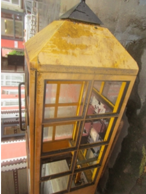
Telefonhäuschen im Roh-Bau
